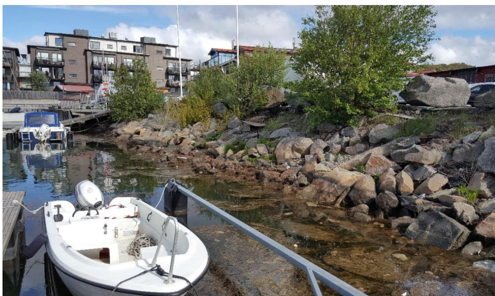
Figur 4 Erosionsskydd sett från den södra bryggan. Vy norrut.
