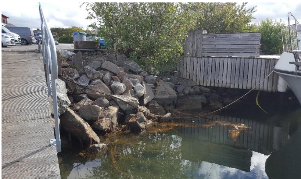
Figur 3 Erosionsskydd vid den södra bryggan. Vy söderut.
